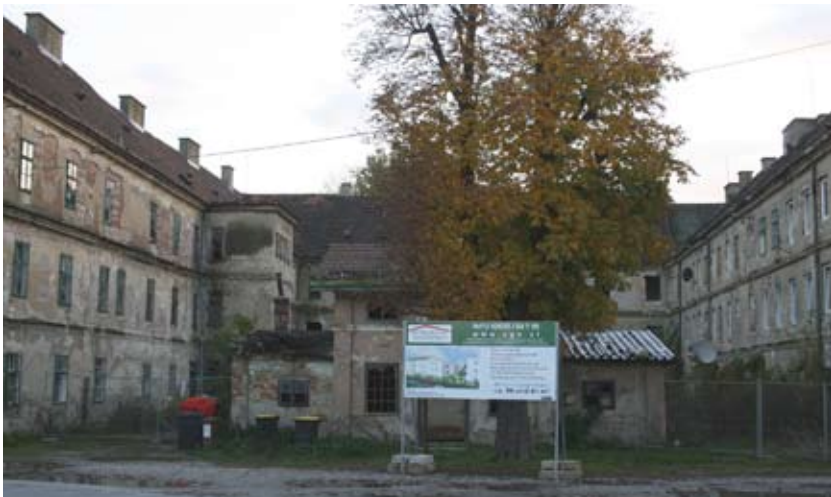
Abbildung 2: Das Altgebäude kurz vor seinem Abriss.
