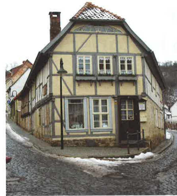
Abb. 4 Alte Elementarschule Gernrode. Das Fachwerkgebäude geht auf die Schulgründung von Anna von Plauen zurück. Heute kann es als Museum besichtigt werden.
