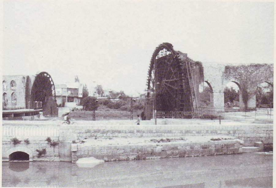
Die berühmten Wasserräder von Hama mit einem Durchmesser von bis zu 20 m heben das Wasser des Orontes auf die Aquädukte
