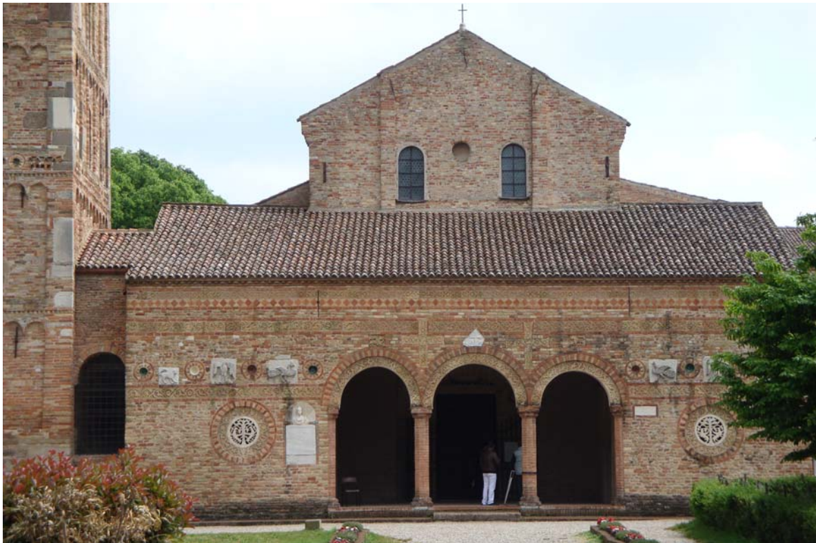
Abb. 4: Der Narthex der Basilika von Pomposa wurde erst nachträglich im 11. Jahrhundert hinzugefügt.
