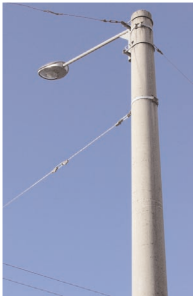
Eine neue, ökologisch günstige Straßenlaterne beim Uni-Park: Der Lichtkegel leuchtet nur nach unten. Foto: Archet
