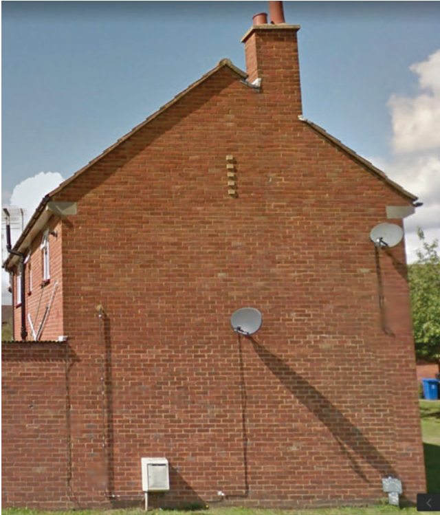
Abb. 3 Haus in London, Seitenwand. (Quelle: Google-Street-View)
